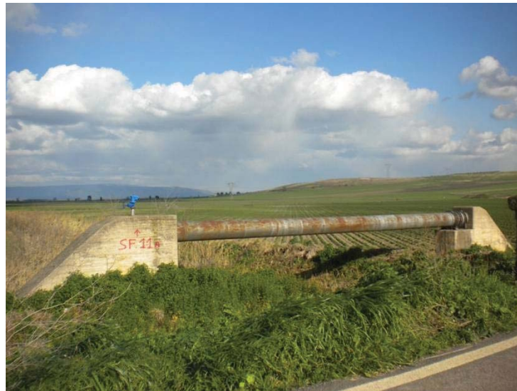
Opere idrauliche in località Castellana (Torremaggiore)
